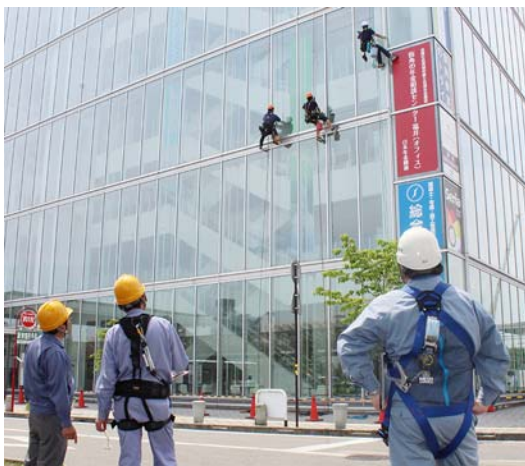
作業状況を確認する協会員ら
